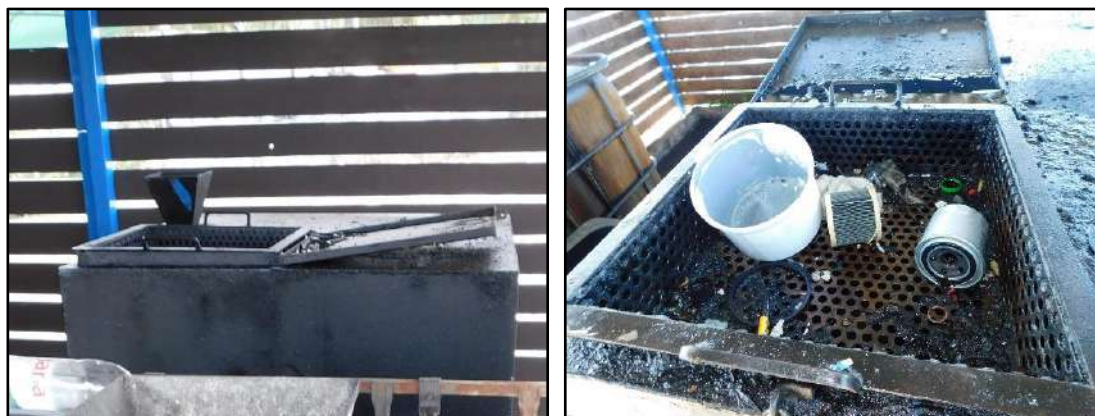
Σίτα επί του στομιού της δεξαμενής, για την αποφυγή απόρριψης στερεών αποβλήτων εντός αυτής
