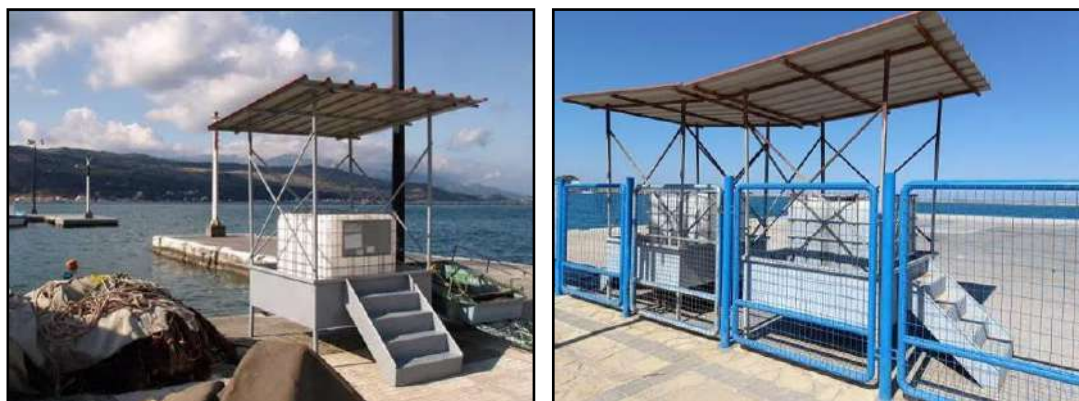
Υποδείγματα Δεξαμενών με στέγαστρο και λεκάνη ασφαλείας με σκαλοπάτια
